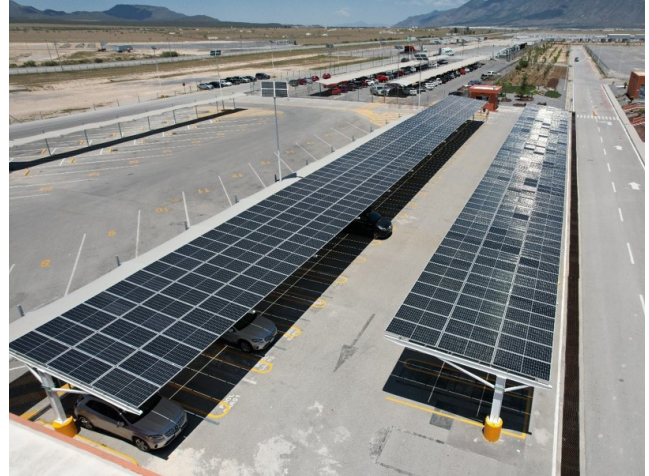
Paneles en la planta de Saltillo
